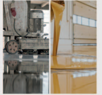
Mekanik Parlatma - Epoksi Zemin Kaplama
