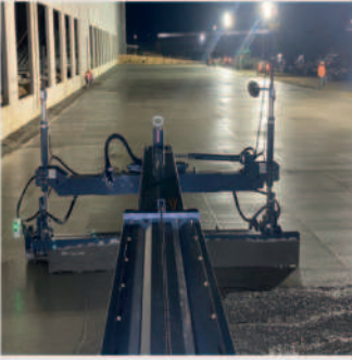
Endüstriyel Beton Sistemleri (Laser Screed)
